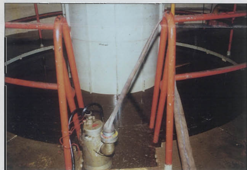
Z prostoru okolo víka turbín elektrárny Orlík je třeba vyčerpávat „naolejovanou“ vodu.
