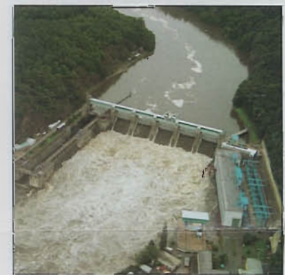
Zaplavená vodní elektrárna Štěchovice
